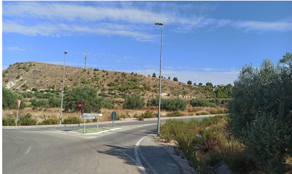
Farola actuales sin servicio a reponer el equipo de iluminación por led. Farola nº 1
