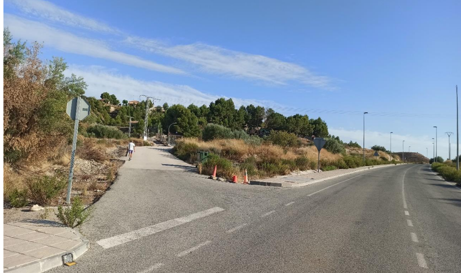
Farolas actuales sin servicio a reponer el equipo de iluminación por led. Farolas nº 4, 5 y 6 Zona instalación farola nueva ubicación nº 3
