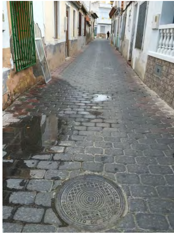
Imagen 6. Calle Morón Pozo 11 P.K.0+219
