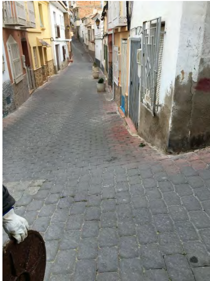
Imagen 13. Calle Triana Pozo 15 P.K. 0+355
