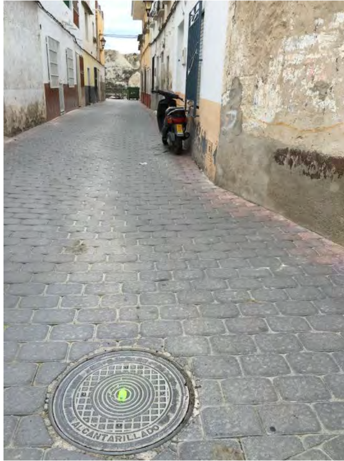
Imagen 8. Tramo final calle Morón Pozo 12 P.K. 0+262
