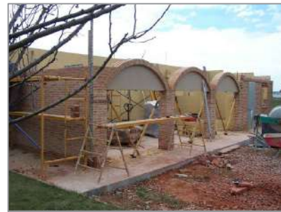
Arcos de ladrillo cara vista macizo, de fabricación manual, de 1 pie de espesor. Reforzada en cada hilada mediante armadura de celosía de 4mm de acero galvanizado y 80mm de anchura tipo Murfor RND 4 y piezas de anclaje a pilares de acero galvanizado tipo Geoanc.1CDM.
