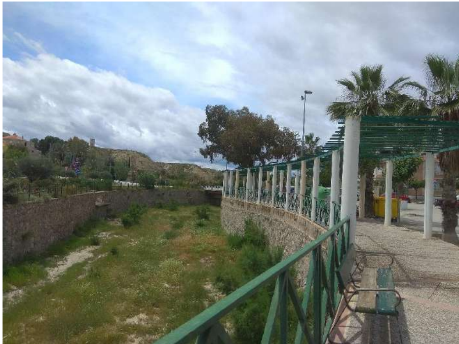
Fotografía nº 8. Mobiliario en mal estado.
