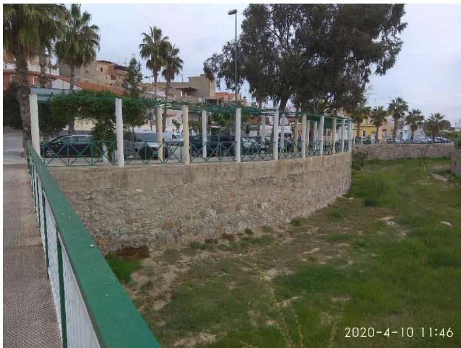
Fotografía nº 6. Vista del Paseo desde la Rambla de los Barrancos.
